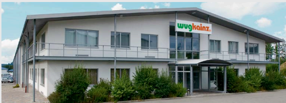
Das Firmengebäude in Irschenberg.
